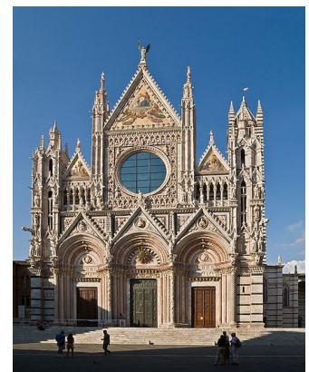
Facciata del Duomo
